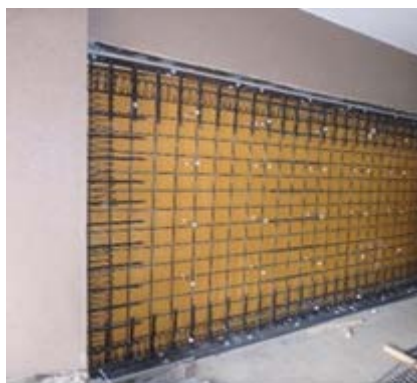
Hアンカー RC 壁接着工法
