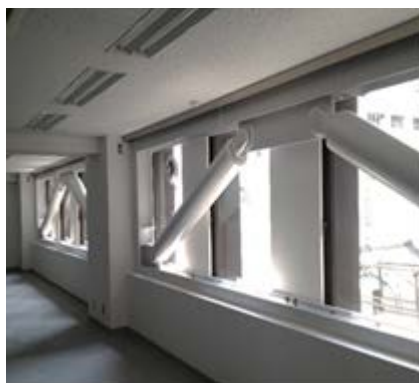
鉄骨ブレース接着工法
