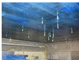
スラブ下面補強
