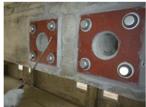
梁貫通孔補強
