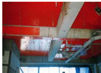
スラブ曲げ・梁せん断補強
