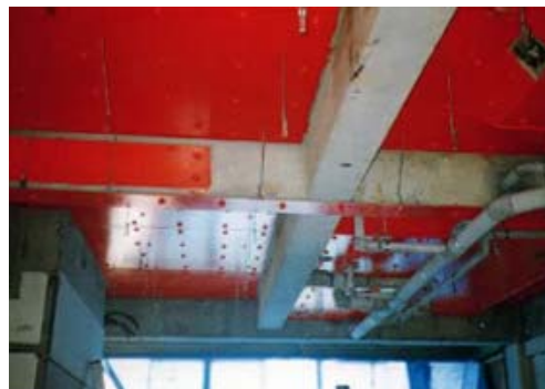
梁補強・スラブ補強
