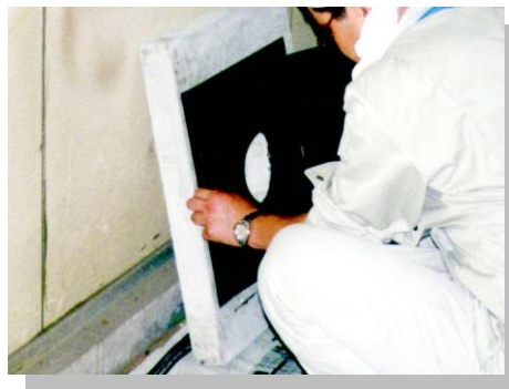
CFRP 板接着
