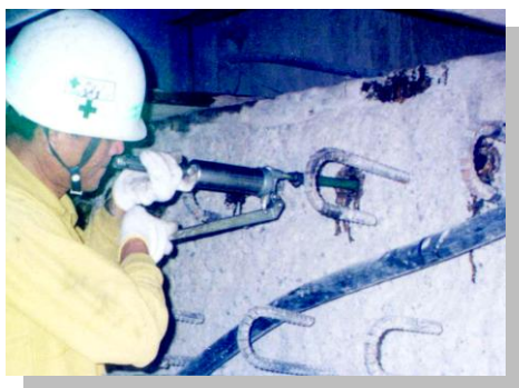
アンカー接着工法
