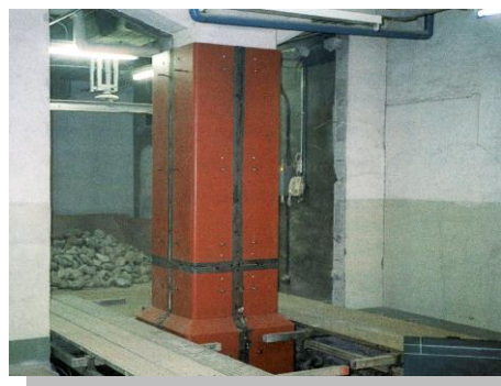
橋脚の鋼板補強
