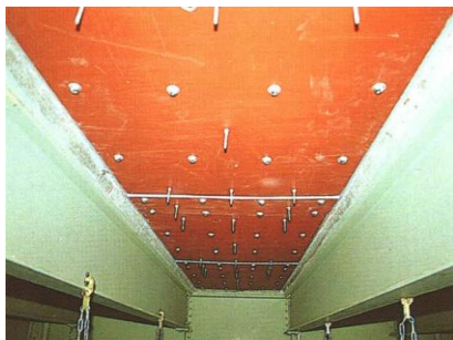
床板鋼板接着工法
