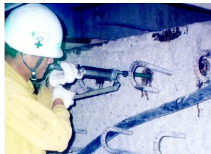
アンカー接着工法
