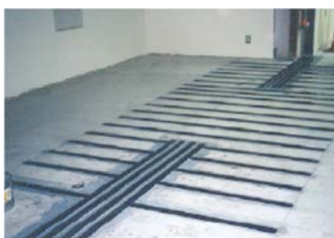
梁上面補強・床スラブ上面補強
