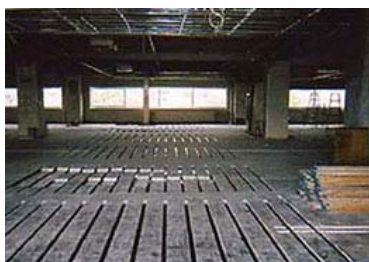
床スラブ上面補強
