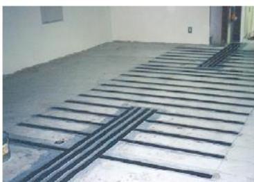
梁上面補強・床スラブ上面補強
