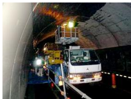
トンネル補強工事
