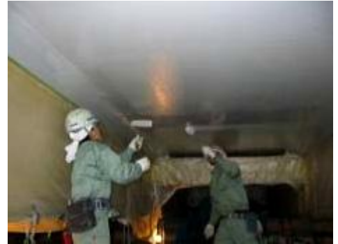
HiPerCF工法施工状況
