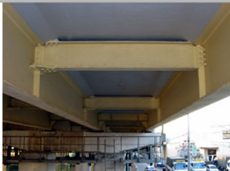
床版補強工事
