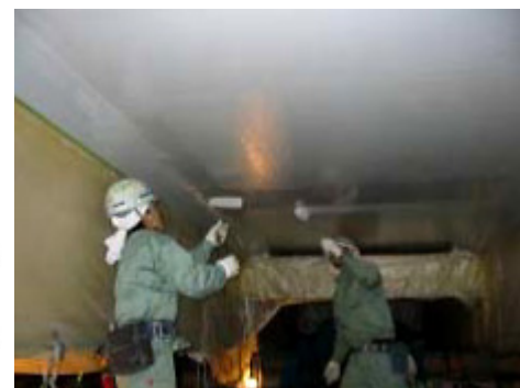
HiPerCF 工法 施工状況
