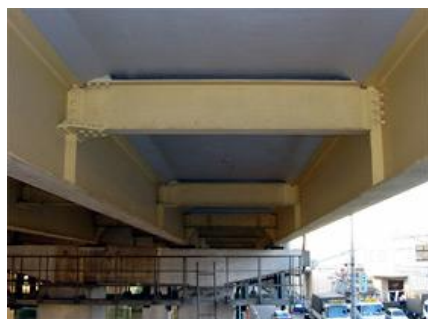
床版補強工事
