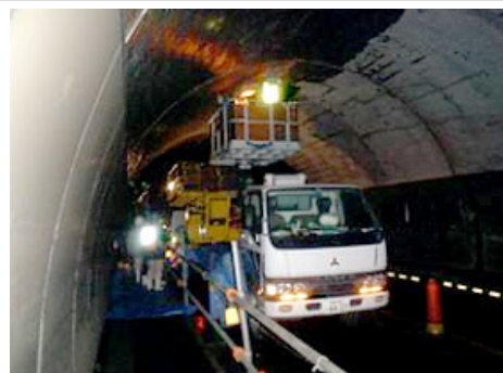
トンネル補強工事
