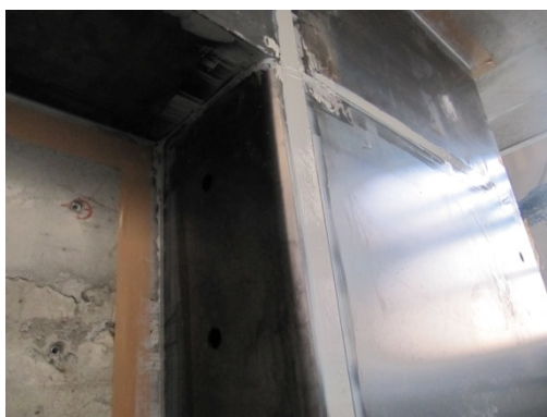
鋼板段差修正状況
