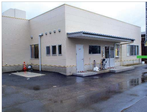
中央管制室（黒埼事業所内）
