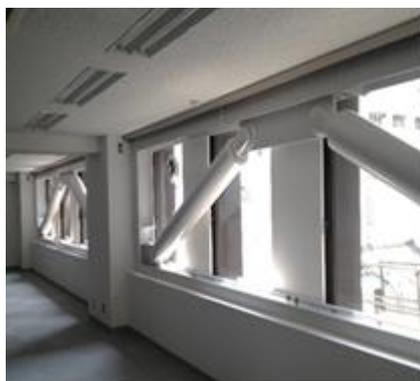
鉄骨ブレース接着工法
