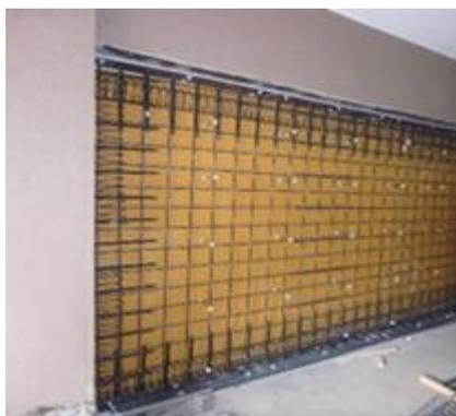
ハンアンカー RC 壁接着工法
