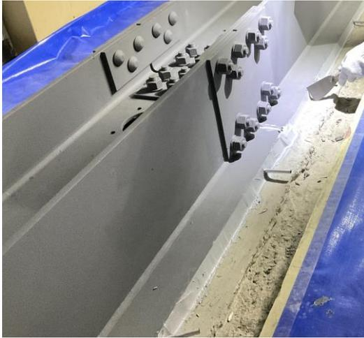
トーホーダイト S930 は、鋼板接着工法の鋼板シールを主用途としたエポキシ樹脂パテ材です。コンクリート断面欠損部やジャンカ等の充填補修材としても使用できます。
