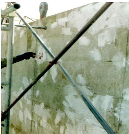
トーホーダイト S900 はコンクリート表面の不陸修正及びコンクリートひび割れ注入工法のひび割れシーリング材としてエポキシ樹脂パテ材です。コンクリートの段差及び凹凸部の充填から全面不陸修正まで幅広く使用できます。
