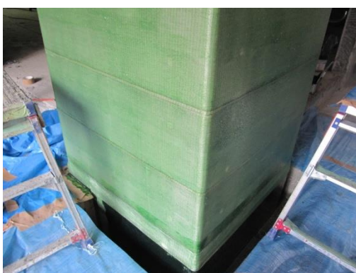
繊維シート貼り付け状況
