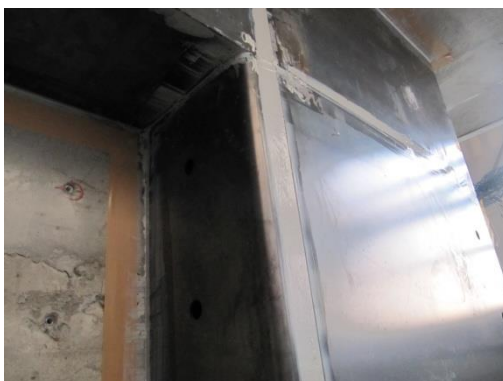
鋼板段差修正状況
