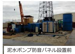
泥水ポンプ防音パネル設置前
