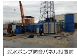
泥水ポンプ防音パネル設置前
