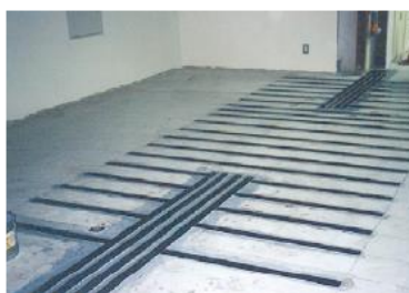
梁上面補強・床スラブ上面補強
