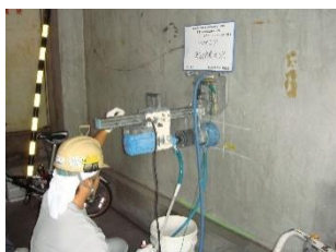
コンクリート強度等試験用のコア採取
